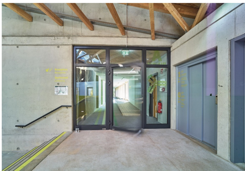
2. kép: A Hörmann T60 keretszerkezetes ajtóelemek egyesítik az átláthatóságot és a tűzgátlási követelményeket
